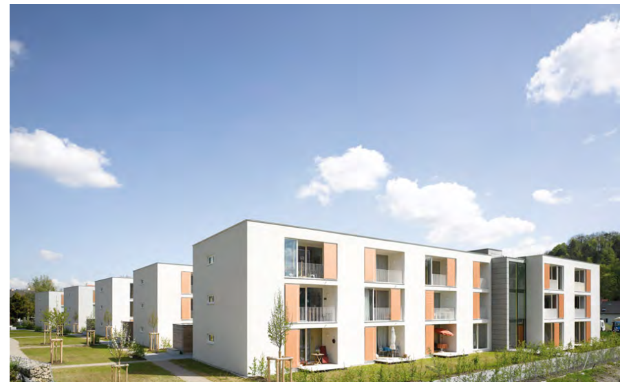
Abb. 4 : Beispiel einer Seniorenwohnanlage in Landsberg am Lech (Architekten: Nickl und Partner; Quelle: http://www.nickl-partner.com/projekte/wohnen/seniorenwohnanlage-am-englischen-garten/ )
